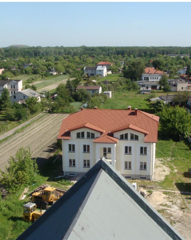
Widok z wieży kościoła w kierunku północnym z 2008 r. Na pierwszym planie wznosi się świeżo ukończona plebania.
